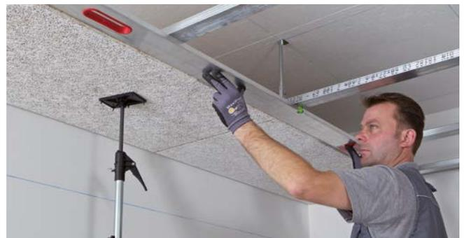
Ausfluchten der Plattenreihen mit Verlegetlatte. Plattenstöße müssen mittig unter
