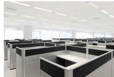
Mit System A setzen wir auf verdeckte Konstruktionsprofile. Die Deckenplatten sind in den unterschiedlichen Konstruktionsvarianten herausnehmbar oder nicht herausnehmbar verlegbar. Angepasst an individuelle Anforderungen ist der Deckenhohlraum damit auch nachträglich noch erreichbar bzw. unzugänglich. Durch die unsichtbaren Profile entsteht eine dezente, ruhige Optik, was maßgeblich zu einem schlichten Deckenbild beiträgt.
