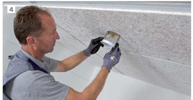
4 Einsetzen des Rahmenteiles eines Spotlights.
