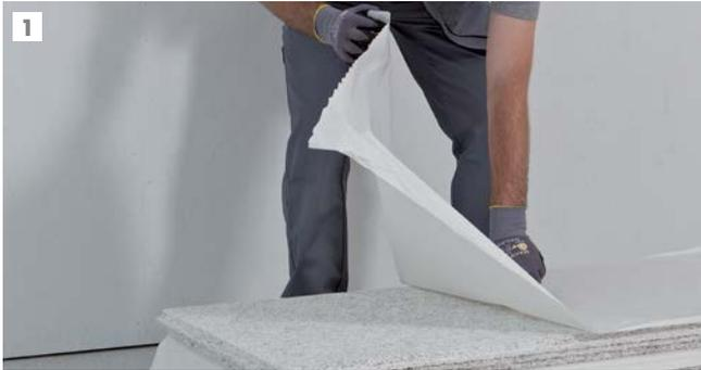
1 Einlagepapier sorgfältig von der Platte abziehen und gleich entsorgen. Darauf liegender Staub darf nicht auf die darunter liegende Platte fallen.
