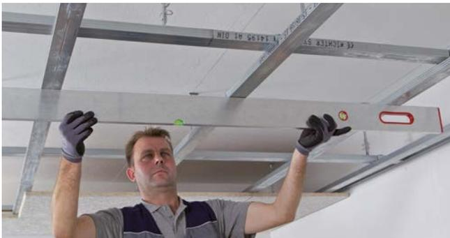
Ausfluchten der CD-Profile mittels Wasserwaage oder Lasergerät.
