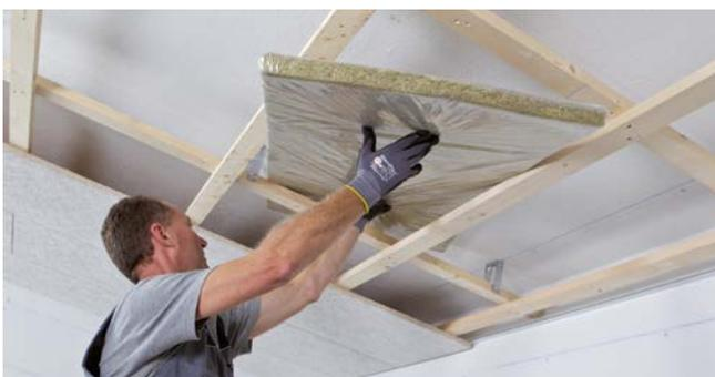
Einlegen von HERADESIGN® Akustikauflage oder anderen akustisch wirksamen Auflagen, Zug um Zug mit der Montage der HERADESIGN® Akustikplatten. Absorberplatten, die zwischen die Holzlatten geklemmt werden, werden auf Maß geschnitten.
