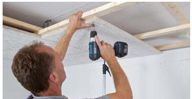
Montage der Akustikplatten mittels Hilfsstütze. Platte während des Schraubens mit dem Handball an die Latte anpressen. Es darf kein Spalt zwischen Platte und Holzlatte entstehen. Bei größeren Decken Beginn der Plattenmontage von der Raummitte aus. Verlegerichtung bei quadratischen Platten beachten!
