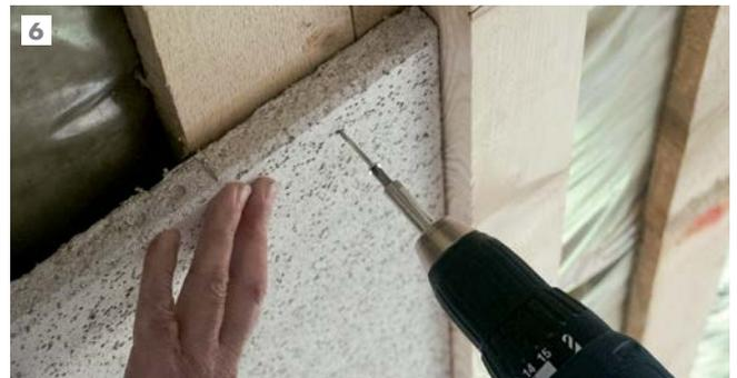
6 Ansetzen der Schraube bzw. der Akustikplatte mit Hilfslatte: Achten Sie auf genügend Abstand zum Plattenrand, um ein Ausbrechen des Randes zu vermeiden. Schraubkopf bündig zur Plattenoberfläche setzen. Die Hilfslatte wird nach Montage der ersten Plattenreihe entfernt. Schraubenschema siehe Kapitel „Geschraubte Systeme“ B10 bzw. B20.
