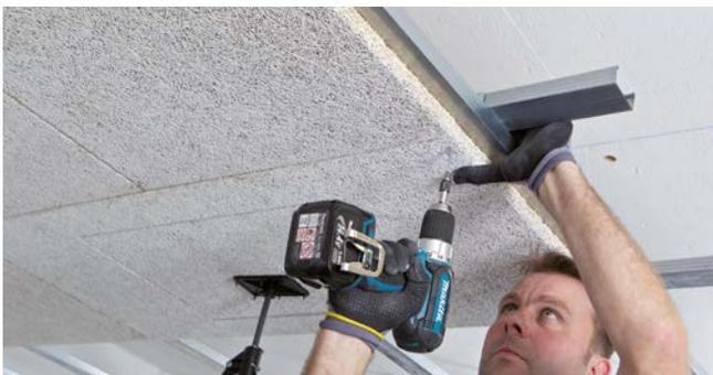
Montage der Akustikplatten mittels Hilfsstütze. Platte während des Schraubens
