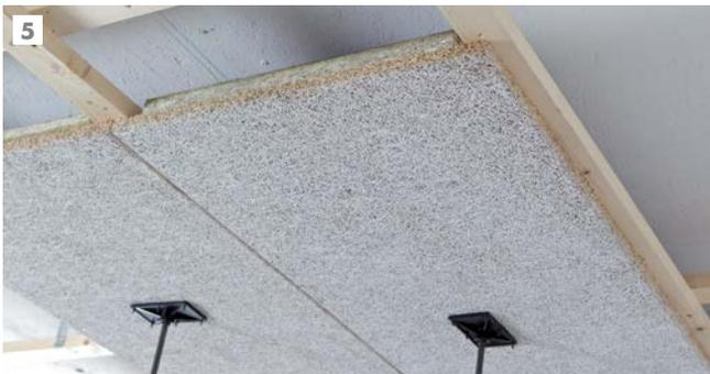
5 Ansetzen der ersten Plattenreihe: Montagebeginn stets von der markierten Raummitte aus. Platten exakt in Längs- und Querrichtung ausfluchten.
