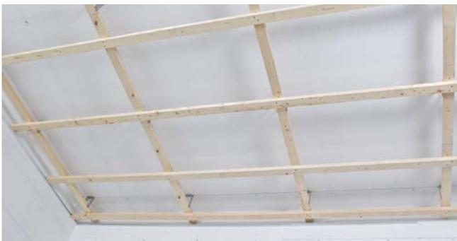
Montage der Grund- und Traglattung. Max Abstände siehe Abstände laut Tabelle „Maximale Abstände der Unterkonstruktion“ für Schraubmontage auf Holzlatten und Detail Anschluss Grundlatte/Traglatte
