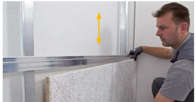
Tragprofil zuerst am Ende nur mit einer Schraube fixieren, so dass das andere Ende in der Höhe beweglich bleibt. Dies vereinfacht das Einschleiben der weiteren Platten.
