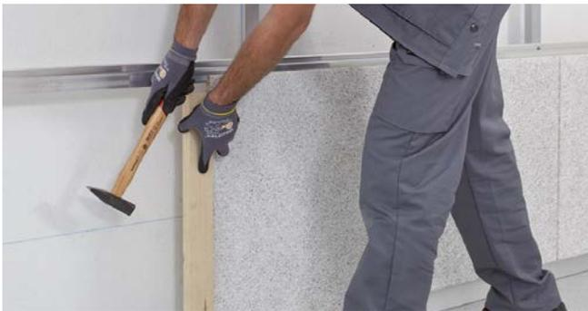
Die Platten müssen pressgestoßen verlegt und in jeder Reihe horizontal und vertikal ausgefluchtet werden. Platten nur mit sauberen Händen verarbeiten.
