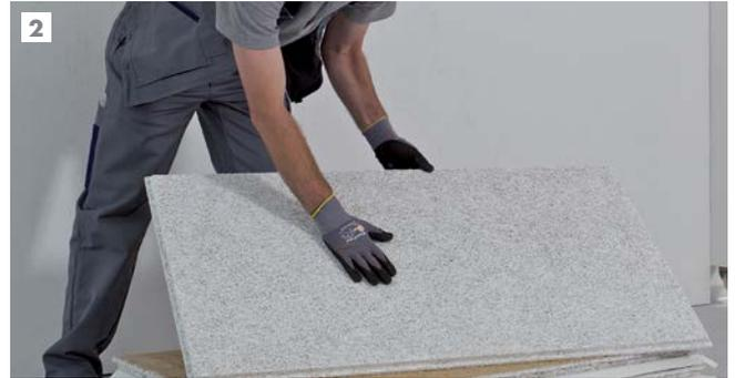
2 Platte auf Beschädigungen überprüfen. Eventuell anhaftenden Staub mit weicher Bürste entfernen.
