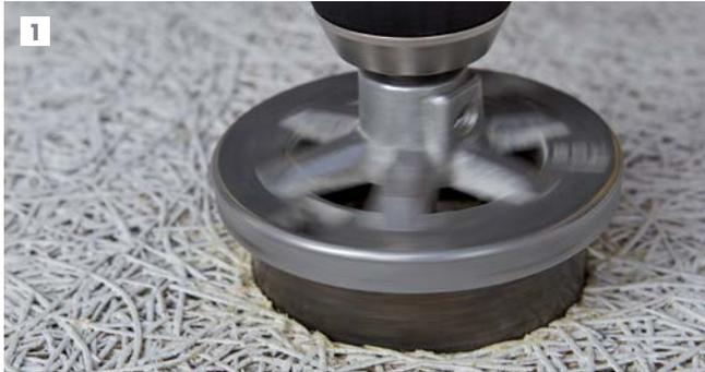
1 Bohren einer Kreisöffnung für Spotlights. Die Sichtseite der Platten ist oben.
