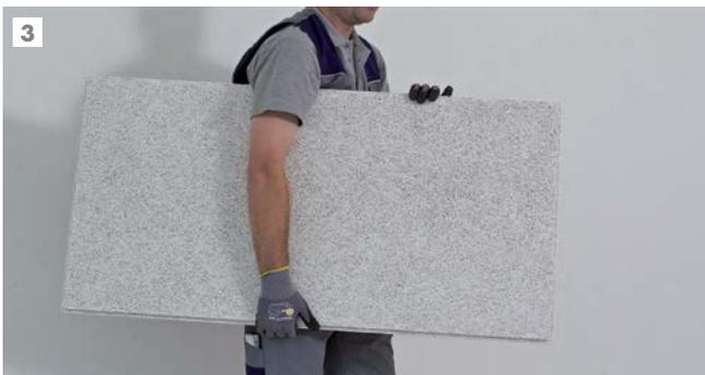
3 Akustikplatten beim Abheben vom Stapel nur hochkant tragen. Platten beim Abheben vom Stapel niemals über die Stapelkante ziehen, um eine Beschädigung der Sichtseite zu vermeiden.
