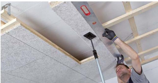
Ausfluchten der Plattenreihen mit Verlegelatte. Plattenstöße müssen mittig unter dem Profil angeordnet sein. Keine freien Plattenstöße zulässig.
