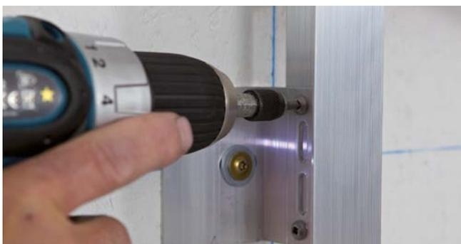
Befestigung der Grundprofile L 60/40/1,8 mm mit je zwei Bohrschrauben 4,8 x 20 mm. Der jeweils zweite Abstandhalter von oben eines Grundprofils wird als Festlager ausgebildet. Die Bohrschrauben werden in die beiden Rundlöcher gesetzt. Alle weiteren Abstandhalter werden als Gleitlager ausgebildet. Höhenausgleich durch Verschieben des Grundprofils im Abstandhalter bis max. 15 mm möglich.
