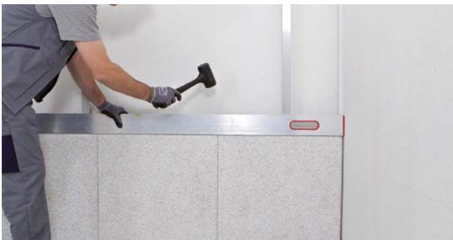
Ausfluchten der Platten und des Tragprofils bevor es mit den Bohrschrauben fixiert wird.
