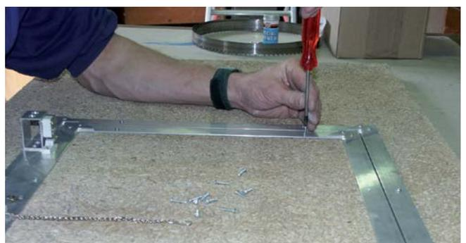
Anschrauben der Deckplatte mit min. 2 x 4 Stück Schrauben 4,5 x 20 mm pro Rahmen 40 x 40 bzw. 2 x 6 Stück bei 60 x 40 cm und Heraklith-BM PU oder Polymerkleber am inneren Rahmen.
