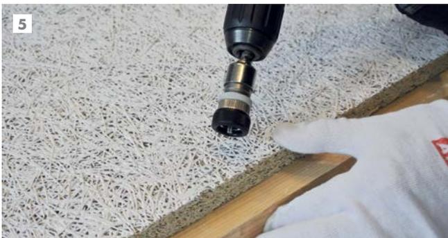
Zum exakten Einsetzen der Schraube empfehlen wir den HERADESIGN® Bitholder „easy“. Die Einschraubtiefe ist vor der Verwendung auf einer Musterplatte genau einzustellen.
