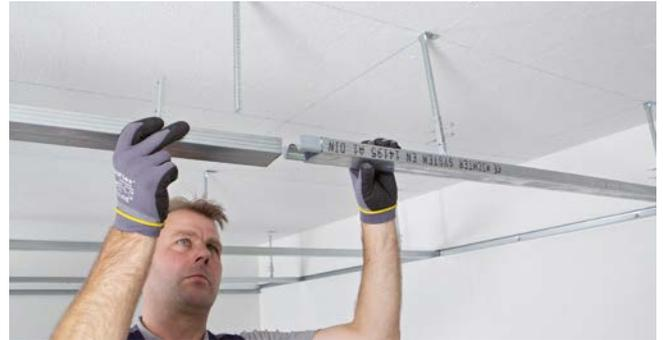
Stöße der CD-Profile versetzt anordnen. Zusätzlicher Abhänger je Profilstoß.
