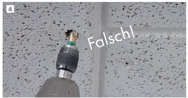
**So nicht!** Schraubenkopf muss mit der Plattenoberfläche bündig gesetzt werden.
