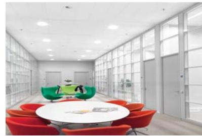
System F als Freigespanntes System ist mit bis zu 2,50 m Spannweite unsere ideale Lösung für Flure. Es ist schnell und effizient, sowohl bei der Montage als auch bei Wartungsarbeiten, da die einzelnen Platten je nach Konstruktionsart herausnehmbar sind und der Deckenhohlraum frei zugänglich ist. Die Platten liegen beidseitig auf Wandwinkeln auf, was die Decke durch den geringen Fugenanteil großflächig und homogen wirken lässt. Der Korridor wird optisch offener und erhält einen hochwertigen Look.
