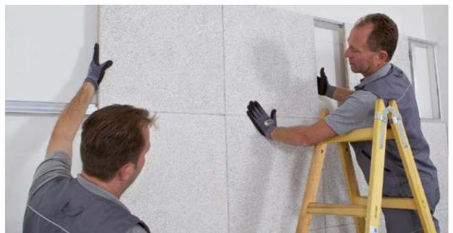
Seitliches Einschleiben der Platten. Randprofil des letzten Feldes wird erst danach montiert.
