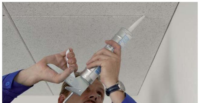
Fugen können bei HERADESIGN® micro Akustikplatten mit Knauf Arcylat Dichtungsmasse ausgefügt werden. Überstreichbar mit Silikatfarbe.
