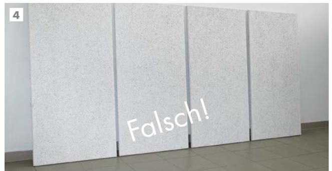
4 Akustikplatten bei Montage und nachträglicher Einfärbung nie schräg gegen die Wand lehnen. Dies bewirkt eine Verwölbung der Platten – verwölbte Platten können nicht mehr eingebaut werden.
