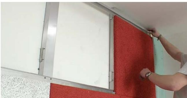
Montage des oberen Randprofils. Platzbedarf zur Decke hin ca. 40 mm. Erste Platte wird ca. 10 cm zur Mitte hin verschoben, die Schrauben gesetzt und danach die Platte endgültig im Raster ausgefluchtet.
